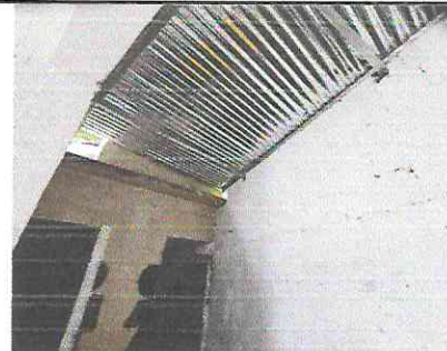
foto 6: Modulo 3 sustitución de puertas de baño
