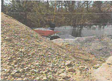
foto 1: Modulo 1 inicio de la obra
