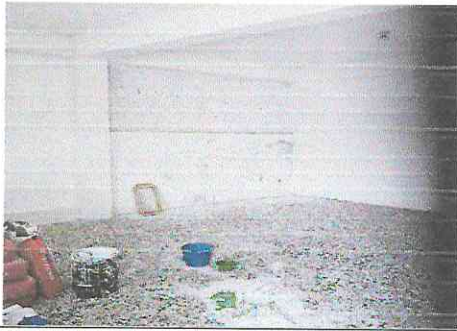
foto 3: Modulo 2 inicio de la impermeabilización del aula
