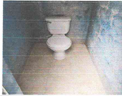
foto 4: Modulo 2 sustitución de batería de baño
