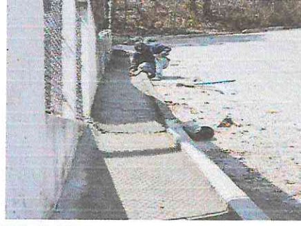
foto 2: Modulo 1 realizando la banqueta con cuneta exterior
